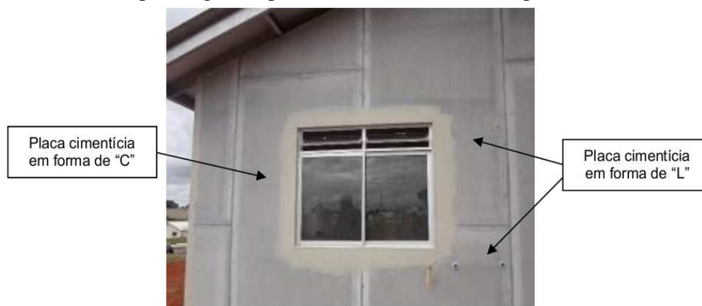
Figura 3 – Paginação das placas cimentícias em aberturas
