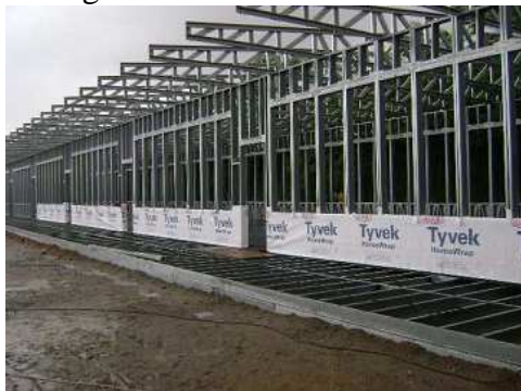
Figura 1 – Instalação pela parte inferior
